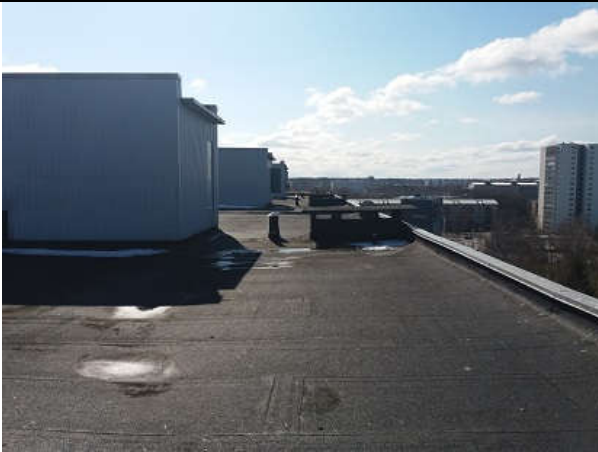
Foto nr. 3. Üldvaade katusele.
