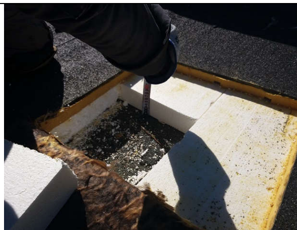
Foto nr. 14. Katuse soojustamise konstruktsioon.
