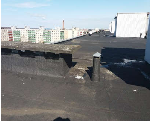
Foto nr. 1-2. Üldvaade katusele.
