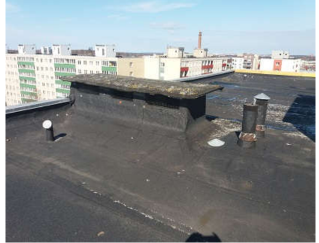
Foto nr. 8. Katuse pind on hooldamata. Parapeti plekk vajab parandamist.
