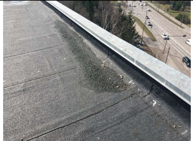
Foto nr. 8. Katuse pind on hooldamata. Parapeti plekk vajab parandamist.
