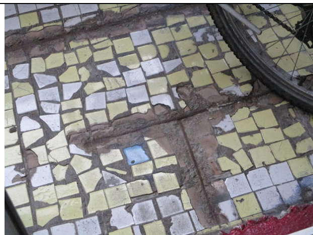
Foto nr. 12. Paneel laguneb, armatuur on väljas.
