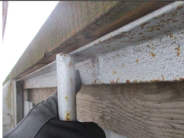
Foto nr. 6. Piirde metallelement on amortiseerunud.
