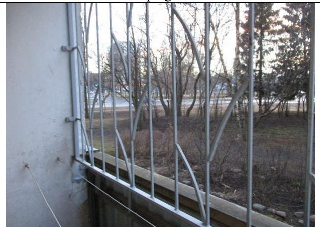
Foto nr. 18. Piirdele on paigaldatud metallvõre.
