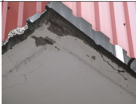
Foto nr. 22. Vahelae paneel laguneb, armatuur on väljas.
