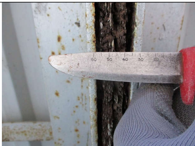
Foto nr. 11. Paneelide vaheline materjal on tugevalt amortiseerunud.
