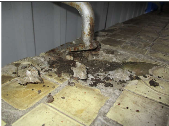
Foto nr. 19. Ehituseagne praak. Kinnituselement on halvasti keevitatud.
