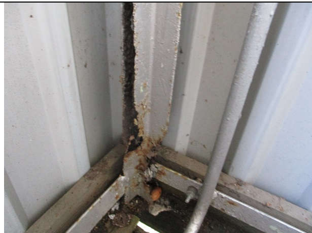
Foto nr. 6. Piirde metallelement on amortiseerunud.
